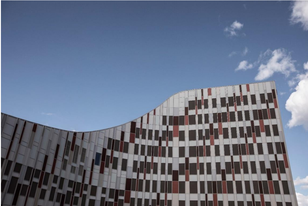
Fastigheten Kajan 18 i Luleå
